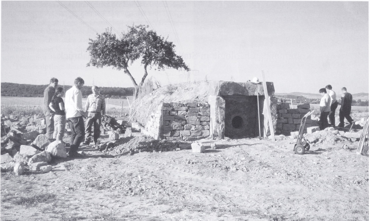
Abb. 1 Großenrode, Ldkr. Northeim. Rekonstruktion der jungsteinzeitlichen Totenhütte II (im Bau).
