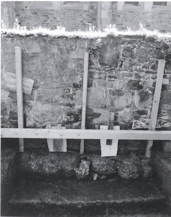
Abb. 5 Ankum, Gde. Ankum, Ldkr. Osnabrück, FStNr. 29. Ansicht der mit Holzbalken armierten nördlichen Umfassungsmauer an Schnitt 1, zur Lage der Findlinge am Mauerfuß.
