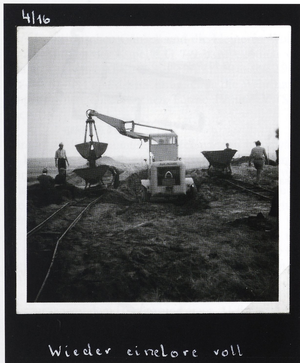
Abb. 4 Werla, Kernburg: Einsatz von Lorenbahnen und eines Raupenbaggers beim Aushub der so genannten „Großen Baugrube“ (1958; Eintrag in den Grabungsunterlagen).
