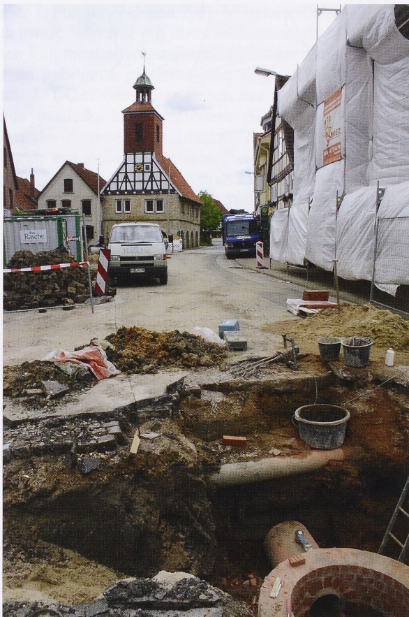
Abb. 15 Der Markt während der Kanalarbeiten 2010 mit Blick auf das Rathaus von 1607.
