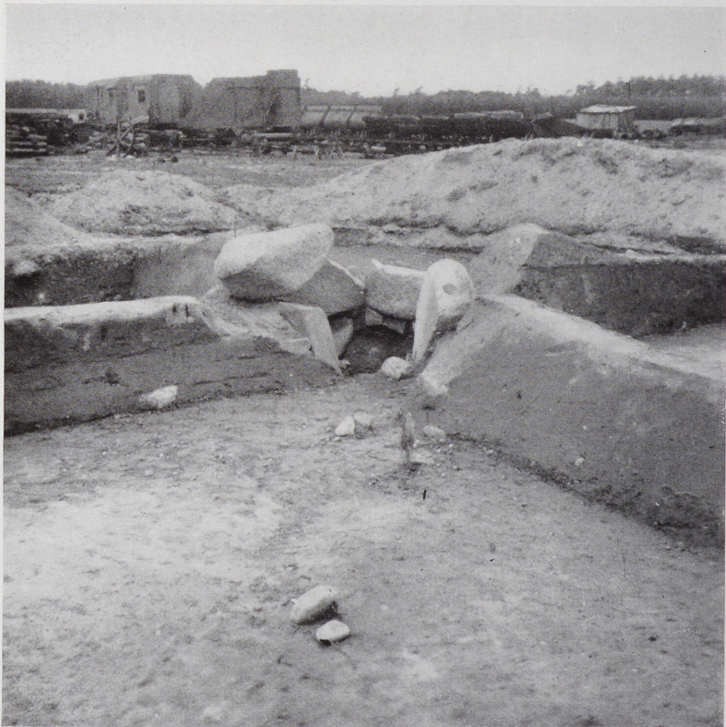
Blick über den Südquadranten des Hügels auf die Grabkammer von Melzingen nach Wiederaufbringung des bei der Zerstörung herabgewälzten Decksteins.
