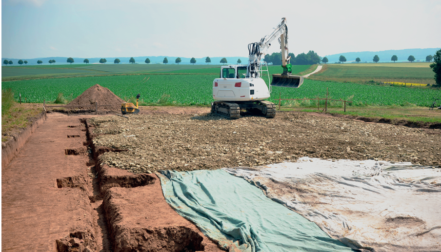
Abb. 8 Pfalz Königsdahlum: Die Unterfütterung der Fundamentplatte mit einem Schotterbett auf Folie wird vorbereitet. Links ein Abschnitt der nördlichen Streifenfundamente sowie die zugehörigen Punktfundamente (Foto: M. C. Blaich, NLD Hannover).
