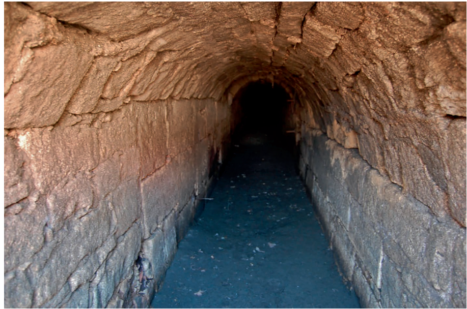
Abb. 343 Wolfenbüttel FStNr. 63, Gde. Stadt Wolfenbüttel, Ldkr. Wolfenbüttel (Kat.Nr. 468). Blick in den freigelegten historischen Abwasserkanal. (Foto: N. Gola)
