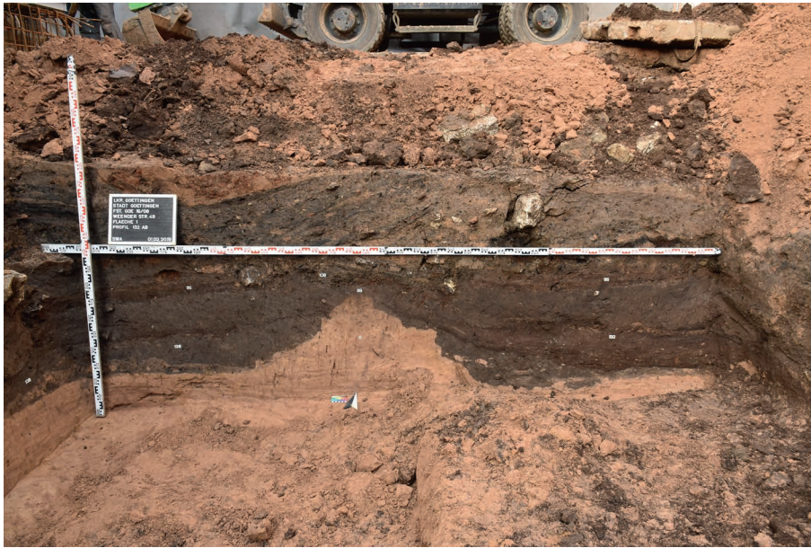
Abb. 100 Göttingen FStNr. 151, Gde. Stadt Göttingen, Ldkr. Göttingen (Kat.Nr. 139). Profil an der nördlichen Grabungsgrenze mit Gruben um 1300. Darüber die Auffüllungen des Handwerksbetriebes und Gebäudereste. (Foto: S. Stoffner)
