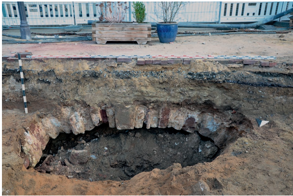
Abb. 345 Wolfenbüttel FStNr. 65, Gde. Stadt Wolfenbüttel, Ldkr. Wolfenbüttel (Kat.Nr. 469). Angeschnittener Gewölbekanal vor Löwenstraße Nr. 1/5. (Foto: B. Feierabend)
