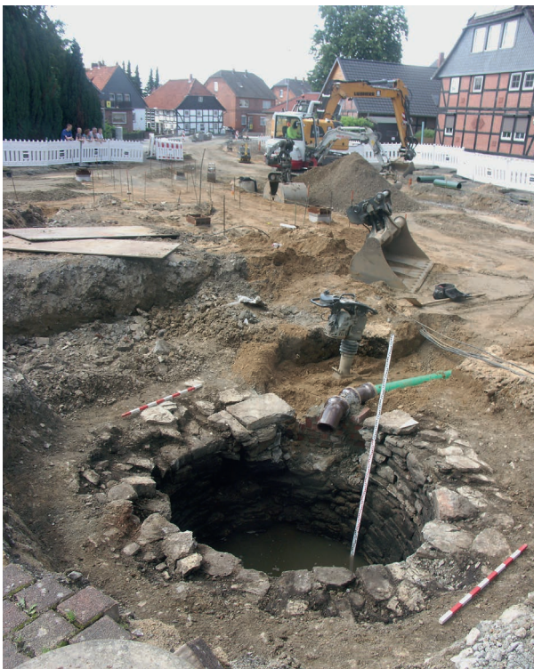
Abb. 255 Gadenstedt FStNr. 140, Gde. Ilsede, Ldkr. Peine (Kat.Nr. 361). Freigelegter Bruchsteinbrunnen aus Muschelkalk vor Junkernberg Nr. 6A (18. Jh.). (Foto: T. Budde)
