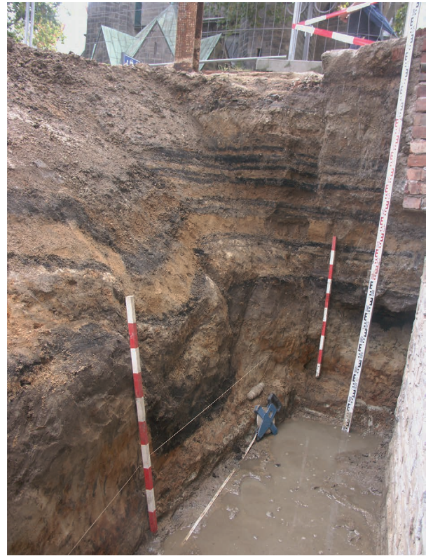
Abb. 258 Peine FStNr. 147, Gde. Stadt Peine, Ldkr. Peine (Kat.Nr. 366). Blick von NNO auf das S-W-Ende des nördlichen Fundamentgrabens für den Neubau Echternplatz Nr. 10. Im Profil zeichnet sich die stadthistorisch aufschlussreiche Stratigraphie vom unteren frühstädtischen Brandhorizont des 13. Jh. über mittelalterliche Brandschichten bis zu den geschichtlich überlieferten Bränden des 16. Jh. ab. Aus Gefahrengründen durfte der obere Böschungsbereich mit den ausgeprägten Stadtbrandschichten von 1592 nicht mehr freigelegt werden. Links eine Siedlungsgrube. (Foto: T. Budde)
