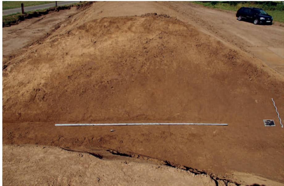
**Abb. 356** Oiste FStNr. 2, Gde. Blender, Ldkr. Verden (Kat.Nr. 398). Schnitt durch den Deich bei Oiste, unter der modernen Deichaufschüttung zeichnet sich der Altdeich als homogene hellere Kleischicht ab. (Foto: D. Behrens)
