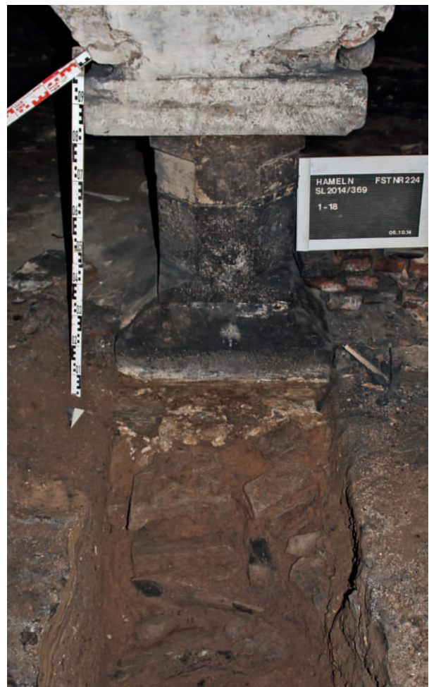
Abb. 69 Hameln FStNr. 224, Gde. Stadt Hameln, Ldkr. Hameln-Pyrmont (Kat.Nr. 112). Fundament eines Pfeilers im Gewölbekeller der Bäckerstraße 44. (Foto: J. Berthold)
