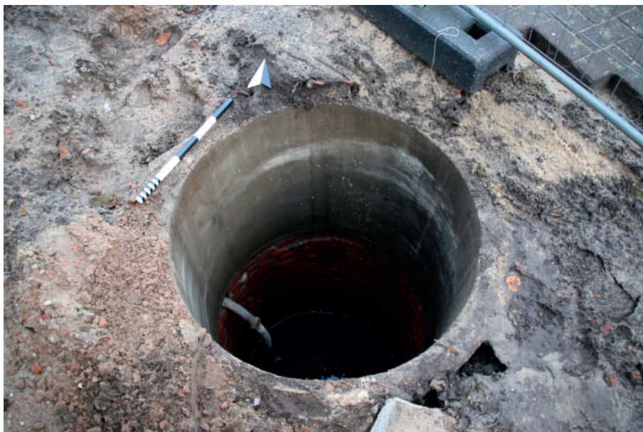
Abb. 209 Rotenburg (Wümme) FStNr. 282, Gde. Stadt Rotenburg (Wümme), Ldkr. Rotenburg (Wümme) (Kat.Nr. 309). Neuzeitlicher Brunnen im Stadtgebiet. (Foto: I. Neumann)
