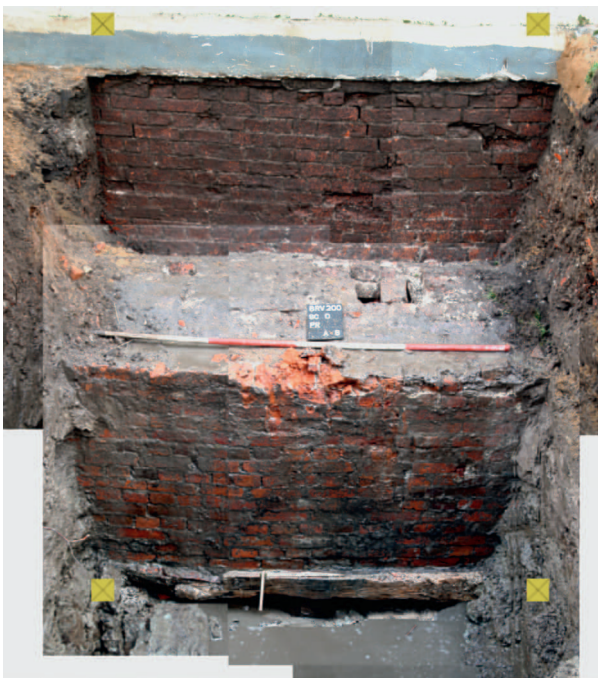
Abb. 207 Bremervörde FStNr. 200, Gde. Stadt Bremervörde, Ldkr. Rotenburg (Wümme) (Kat.Nr. 307). Abwasserkanal mit darunter liegender Pfahlrost-Konstruktion am Kanzleiflügel des Bremervörder Schlosses. (Foto: I. Neumann)
