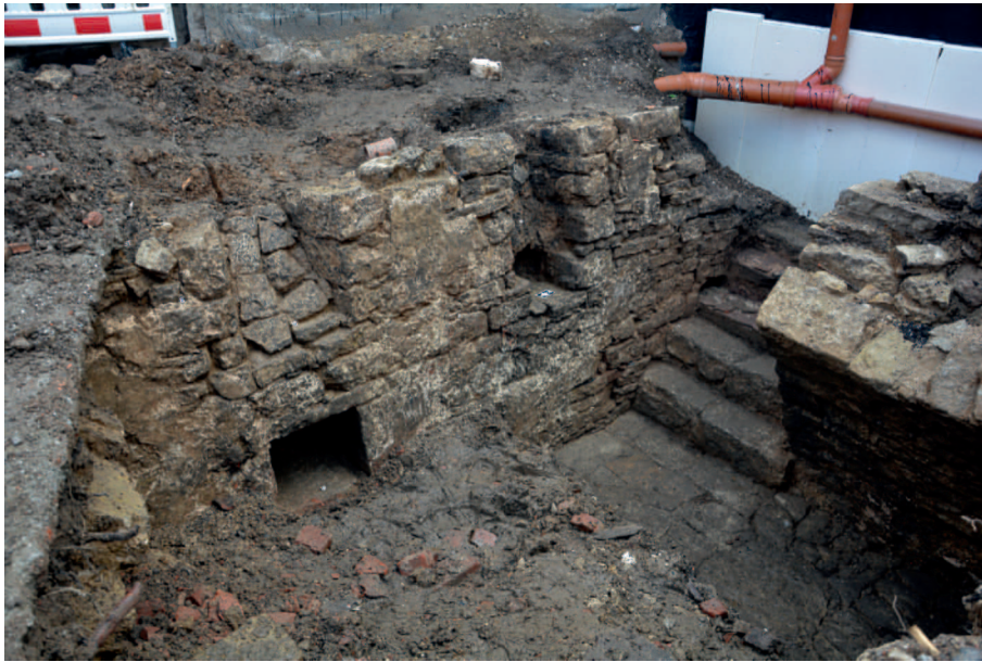
Abb. 180 Bad Gandersheim FStNr. 38, Gde. Stadt Bad Gandersheim, Ldkr. Northeim (Kat.Nr. 267), Südostseite des Kellers mit Lichtschächten (Befund 15 und 16) und Lichtnische (Befund 18). (Foto: S. Stoffner)
