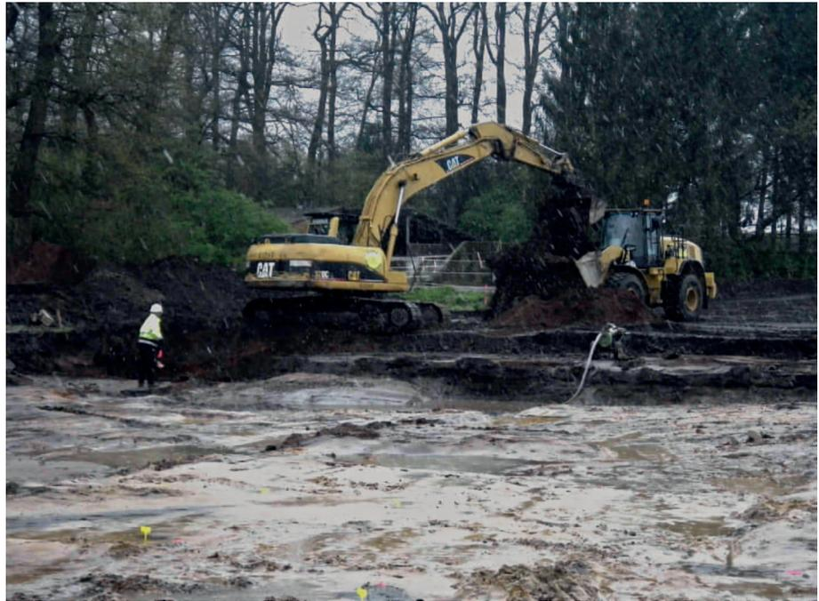
**Abb. 266** Lohne FStNr. 64, Gde. Stadt Lohne (Oldb.), Ldkr. Vechta (Kat.Nr. 318). Abtrag des Oberbodens mittels Bagger unter archäologischer Aufsicht. (Foto: A. Janßen)
