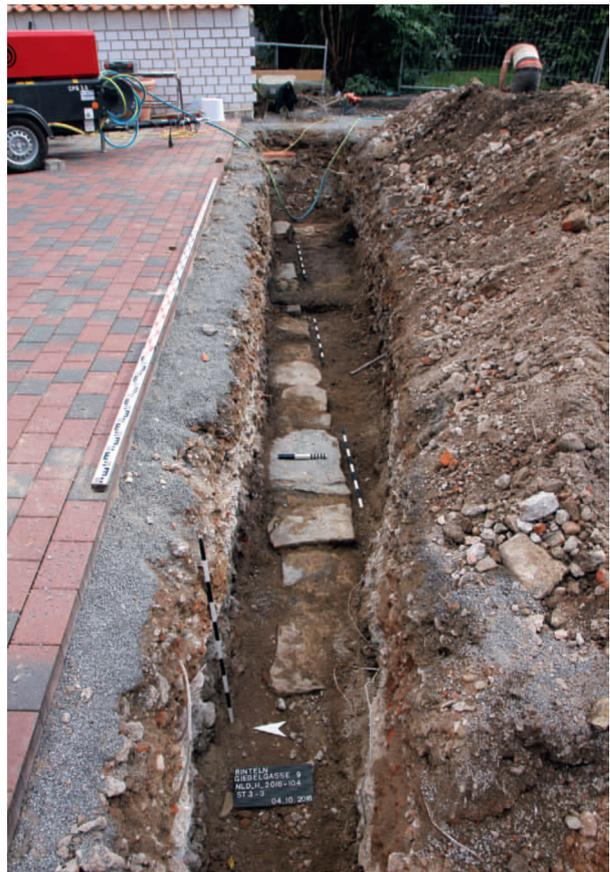
**Abb. 240** Rinteln FStNr. 90, Gde. Stadt Rinteln, Ldkr. Schaumburg (Kat.Nr. 286). Frühneuzeitliches Bruchsteinfundament. (Foto: J. Schween)
