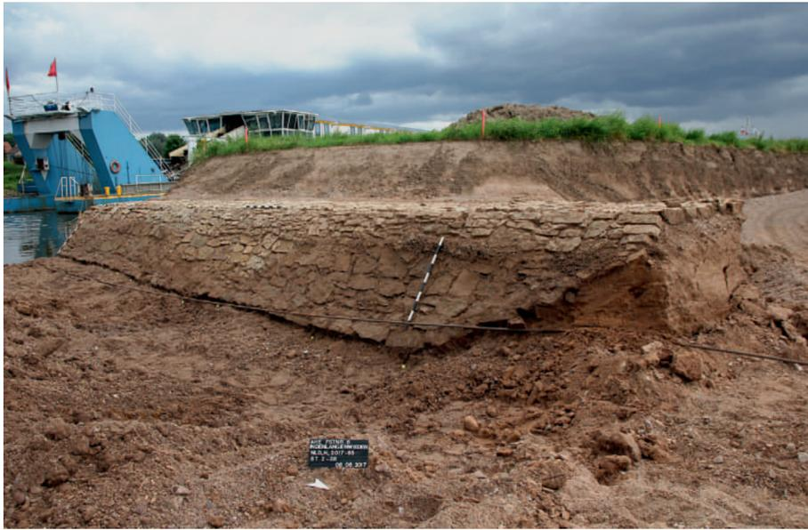
**Abb. 294** Ahe FStNr. 6, Gde. Stadt Rinteln, Ldkr. Schaumburg (Kat.Nr. 332). Bruchsteindamm an der Weser nach der vollständigen Freilegung mit gelben Markierungen vorgefundener Holzpflocke entlang der Dammbasis. (Foto: J. Schween)
