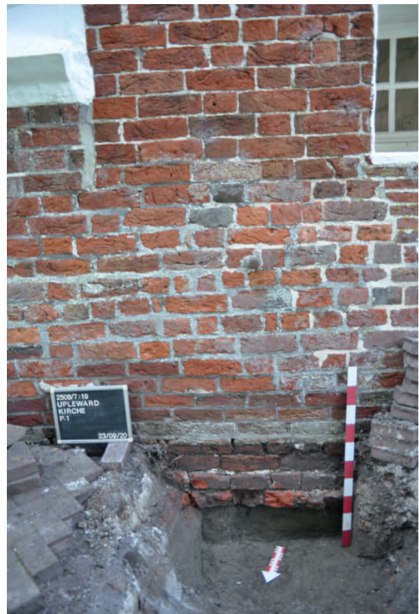
Abb. 25 Upleward FStNr. 8, Gde. Krummhörn, Ldkr. Aurich (Kat.Nr. 25). Profil des Fundamentes an der Nordseite der Kirche. (Foto: I. Reese)
