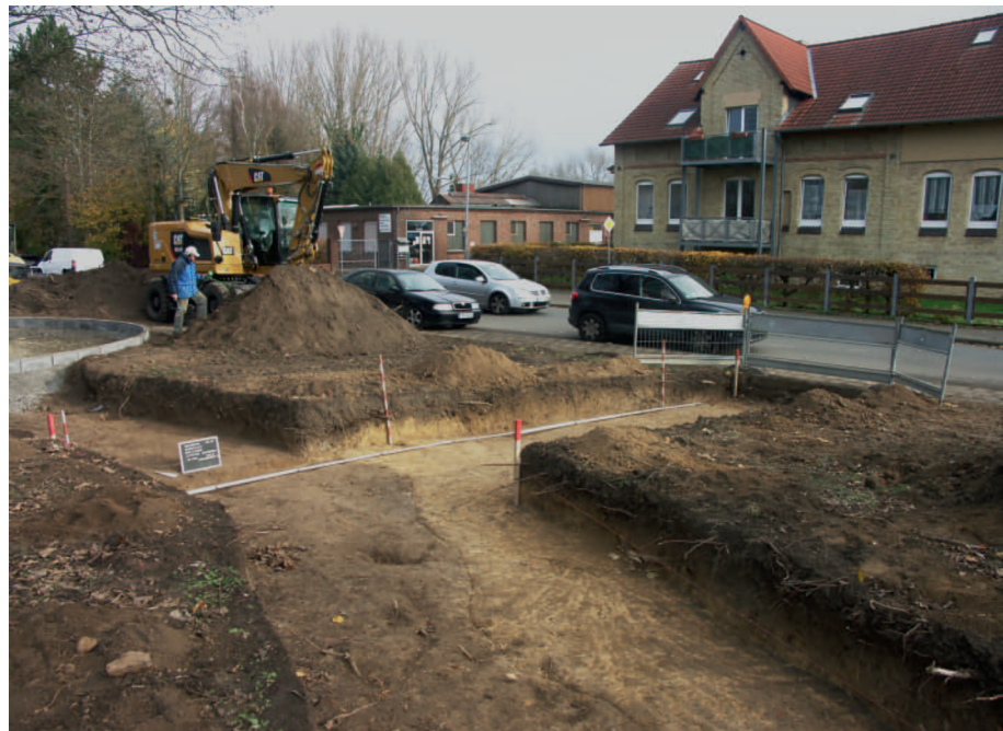
Abb. 269 Ölsburg FStNr. 139, Gde. Ilsede, Ldkr. Peine (Kat. Nr. 376). Unter dem vierten Stichweg zeichnete sich noch gut der aus gelbem Lösslehm bestehende Wallfuß des Burgwalles der Ölsburg ab, während die Wallmauer fast vollständig unter dem Bürgersteig liegt. (Foto: T. Budde)
