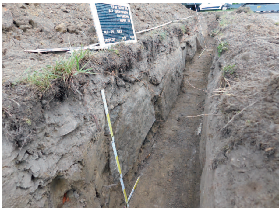
Abb. 70 Alt Isenhagen FStNr. 4, Gde. Hankensbüttel, Ldkr. Gifhorn (Kat.Nr. 99). Fundament aus gebrochenen Findlingen. (Foto: K. J. Borchert)
