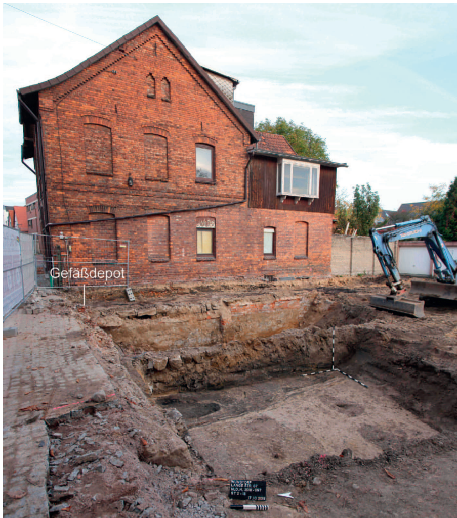
Abb. 134 Wunstorf FStNr. 51, Gde. Stadt Wunstorf, Region Hannover (Kat.Nr. 203), Grundstück „Lange Str. Nr. 87“, Blick gegen Osten. Im Vordergrund Bereich für einen Technik-Keller des Neubaus mit mittelalterlichen Grubenbefunden und grabenähnlicher Struktur. Hinten links Stelle des deponierten Dreibeintopfes. (Foto: J. Schween)
