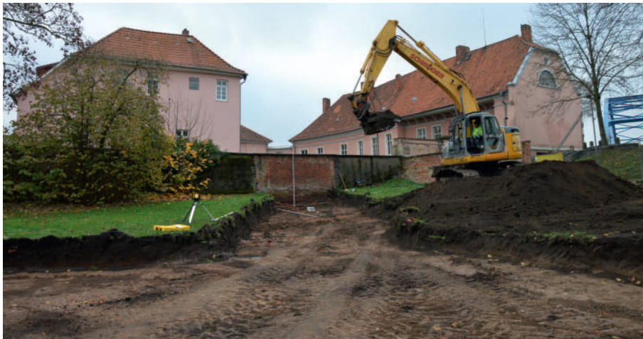
Abb. 211 Hoya FStNr. 6, Gde. Stadt Hoya, Ldkr. Nienburg (Weser) (Kat.Nr. 281). Bodenabtrag für die geplante Schlosszufahrt, die im Bereich einer neuzeitlichen „Ziegelplombe“ in der über 2m hoch erhaltenen historischen Mauer angelegt ist. (Foto: D. Rathert)
