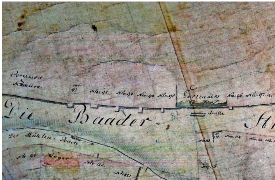
Abb. 172 Schöningen FStNr. 27, Gde. Stadt Schöningen, Ldkr. Helmstedt (Kat.Nr. 242). Westlicher Bereich der Baderstraße im Jahre 1802 (Ausschnitt genordet) mit Einzeichnung einer „Quelle“. Die nicht eingezeichnete Holzwasserleitung ließ sich bis vor das Grundstück Nr. 96 (Baderstraße Nr. 26) sicher verfolgen. (Foto: Stadtarchiv Schöningen)
