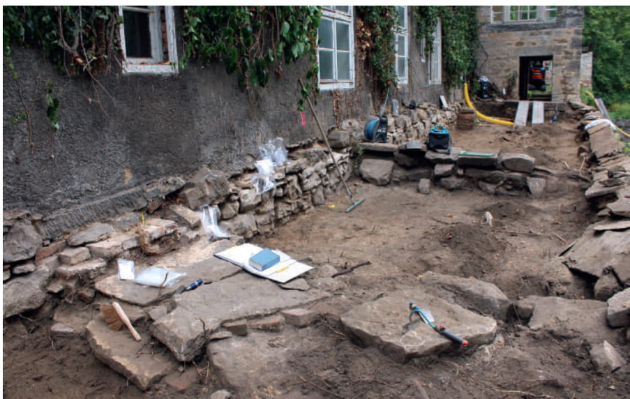
Abb. 118 Bennigsen FStNr. 25, Gde. Stadt Springe, Region Hannover (Kat.Nr. 150). Die steingefassten und mit Steinplatten abgedeckten Abwasserkanäle in der südlich des Anbaus liegenden Fläche zwischen Herrenhaus und Graftmauer während der Freilegung. (Foto: U. Bartelt)
