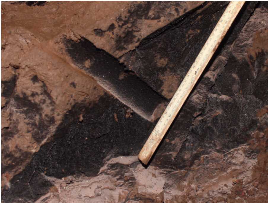
Abb. 96 Clausthal FStNr. 150, Gde. Berg- und Universitätsstadt Clausthal-Zellerfeld, Ldkr. Goslar (Kat.Nr. 132). Das einzige im ganzen Stollenverlauf angetroffene Bohrloch mit einem Durchmesser von 5,3 cm. (Foto: G. Drechsler)
