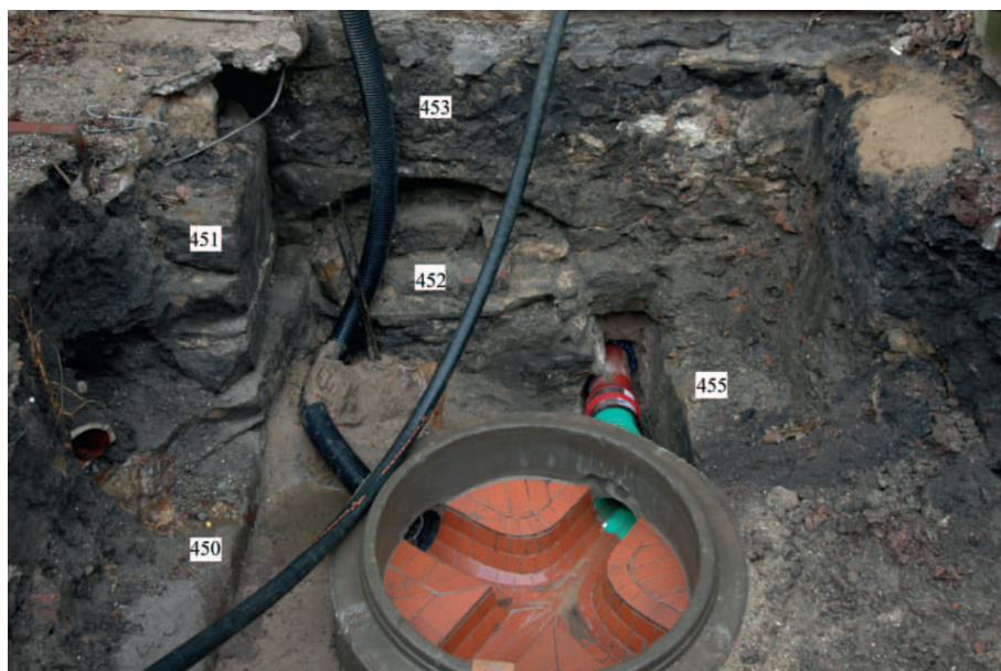
Abb. 219 Loccum FStNr. 1, Gde. Stadt Rehburg-Loccum, Ldkr. Nienburg (Weser) (Kat.Nr. 285). Mauern und Fundamente in einem Schacht an der Westseite des Westflügels. Blick nach Osten. (Foto: R. Landwehr)
