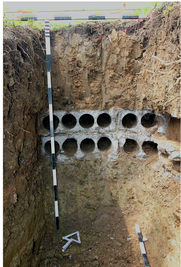
Abb. 110 Hagenohsen FStNr. 13, Gde. Emmerthal, Ldkr. Hameln-Pyrmont (Kat.Nr. 160). Dokumentations- und Lernort Bückeberg, ehemalige Ehrentribüne. Angeschnittene Leerrohrsteine (sog. Kabelzugplatten) der ehemaligen technischen Infrastruktur in der Baugrube für Fundamente eines neuen Besuchersteiges, westlich des Mittelweges. (Foto: J. Schween)
