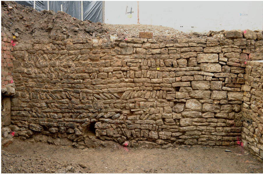
Abb. 81 Goslar FStNr. 188, Gde. Stadt Goslar, Ldkr. Goslar (Kat.Nr. 117). Befundkomplex 22, opus spicatum in der Seitenwand des Kellers. (Foto: Arcontor Projekt GmbH)
