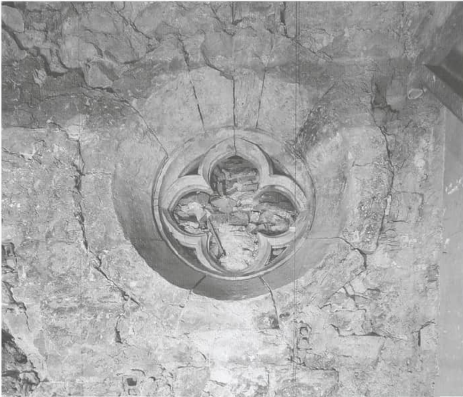
Abb. 124 Hildesheim FStNr. 18, Gde. Stadt Hildesheim, Ldkr. Hildesheim (Kat.Nr. 141) Ehemals zugemauerte gotische Fensterrosette mit vollständig erhaltenem Maßwerk in der Westwand der St. Antoniuskirche, Zustand nach Freilegung der Westseite. (Foto: Kirchliche Denkmalpflege Hildesheim)
