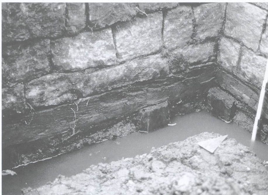
Abb. 212 Wolfsburg FStNr. 9, Gde. Stadt Wolfsburg, KfSt. Wolfsburg (Kat.Nr. 341) Detail der Spickpahlgründung in der Nordwestecke der äußeren Einfassungsmauer des inneren Wassergrabens. (Foto: H. Valand)
