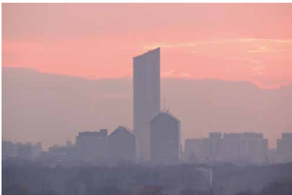
Il. 4 Sky Tower , widok od północnego-wschodu w godzinach wieczornych, na pierwszym planie zespół wieżowców przy pl. Grunwaldzkim, 2016. Fot. Ewa Grochowska
