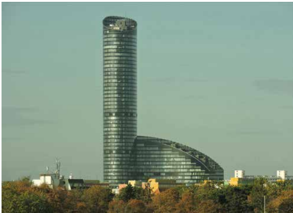
Il. 3 Sky Tower , widok od południowego wschodu, 2016. Fot. Ewa Grochowska
