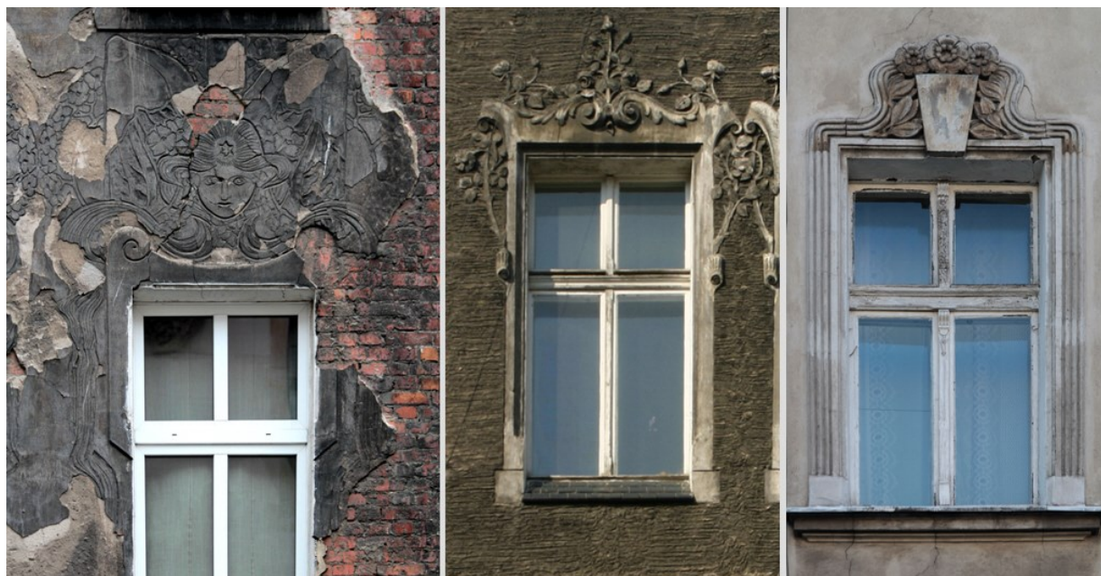
Il. 5. Obramienia okienne elewacji kamienicy przy ul. Rozbrat 16, ul. Parkowej 34, ul. Kleczkowskiej 11; fot. A. Witkowska, A. Gryglewska, 2014
