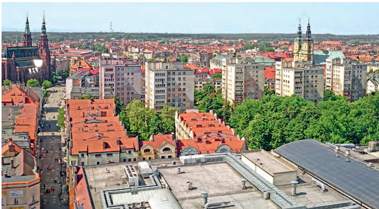
Il. 2 Widok na powojenny dorobek urbanistyczno-architektoniczny starego miasta w Legnicy, stan dzisiejszy. W tle zrealizowane „Osiedle Centrum” wg konkursu SARP z 1965 r., po lewej zabudowa w konwencji retrowersji wzdłuż ul. N.M. Panny, na pierwszym planie modernistyczna galeria handlowa z przełomu XX i XXI w. Fot. Dariusz Wędzina
