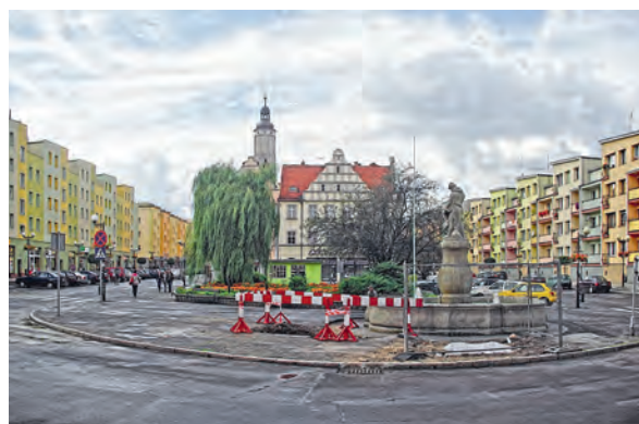
Il. 4 Rynek (pl. Wolności) we Lwówku Śląskim, stan obecny. „Modernistyczne” realizacje z lat 60., po termomodernizacji i w nowej kolorystyce z końca XX w. Fot. Dariusz Wędzina
