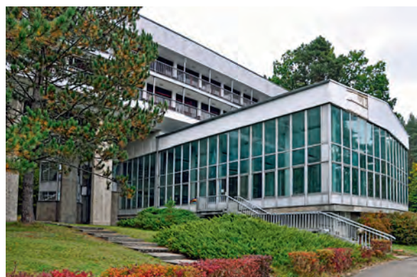
Il. 3 Ośrodek leczniczo-wypoczynkowy KC PZPR w Mierkach, fragment budynku głównego – widok od strony jeziora, stan z 2015 r. Fot. Agata Szmítowska
