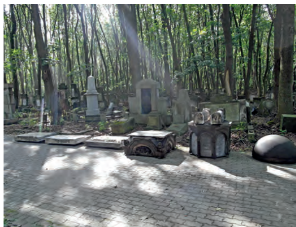
II. 25 Nagrobek Magnusa Kryńskiego (kwatery 64, rz. 2), stan w trakcie konserwacji, fot. Magdalena Olszowska, 2016
