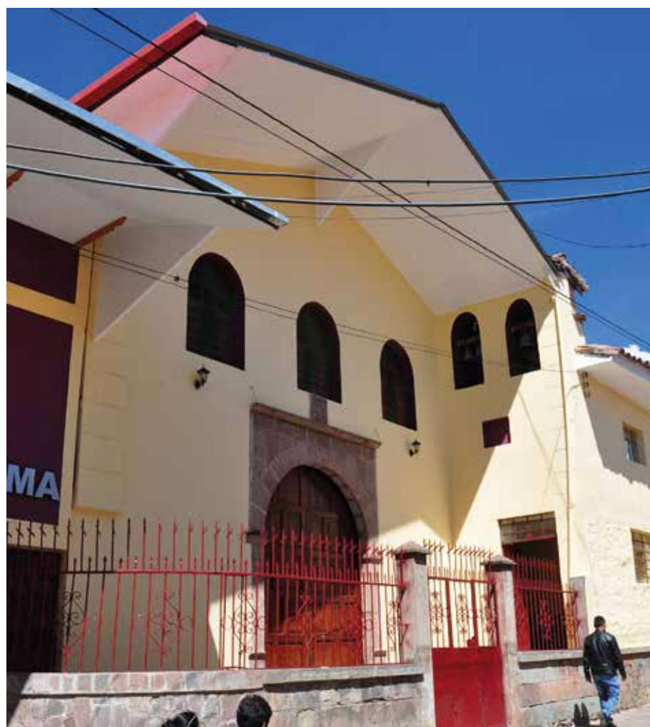
Il. 2. Fasada nowej kaplicy św. Róży, budowla wzniesiona w 1954 r., fot. E. Kubiak, 2018
