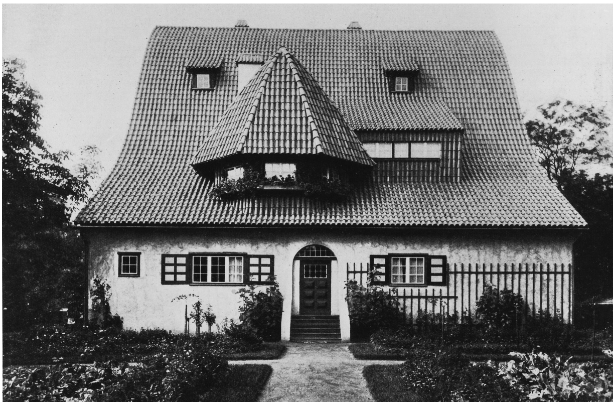
Il. 7. Dom jednorodziny na Wystawie Rzemiosła i Rzemiosła Artystycznego we Wrocławiu w 1904 r., widok elewacji zachodniej i fragmentu ogrodu warzywnego; fot. reprodukowana w: K. Masner, Das Einfamilienhaus des Kunstgewerbevereins für Breslau... , s. 23
