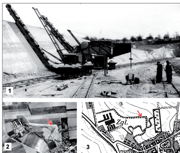
Abb. 3. Ziegeleigrube Coenen. 1: Blick entlang der Nordwand (um 1940). Eimerkettenbagger und Loren auf Schienen. Im hinteren Teil der Nordwand wurde später die Fundschicht entdeckt. Fotoarchiv des Geschichtsvereins Körrenzig (Hans-Joachim Hansen). 2: Luftbild der Ziegeleigrube aus dem Jahr 1958 mit Markierung der Fundstelle. Datengrundlage: Katasteramt des Kreises Düren. 3: Position der Fundstelle in der Nordwand der Ziegeleigrube. Datenbasis: TK 25 von 1966, Landesvermessungsamt NRW.
