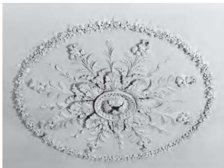
il.7 Rozeta na suficie. Michał Ceptowski, 1804 r. Stan po konserwacji. Fot. E. Andrzejewska
