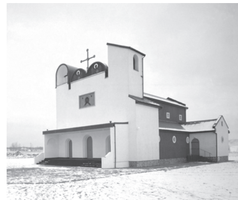
il.13 Jerzy Nowosielski, greckokatolicka cerkiew w Białym Borze, fot. Wojciech Kryński, ze zbiorów Muzeum Architektury we Wrocławiu
