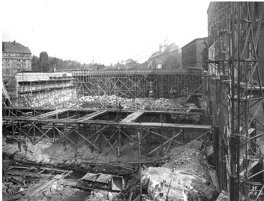
il.14 Budowa Elektrowni Południowej, fot. z ok. 1920 r.; za: internet
