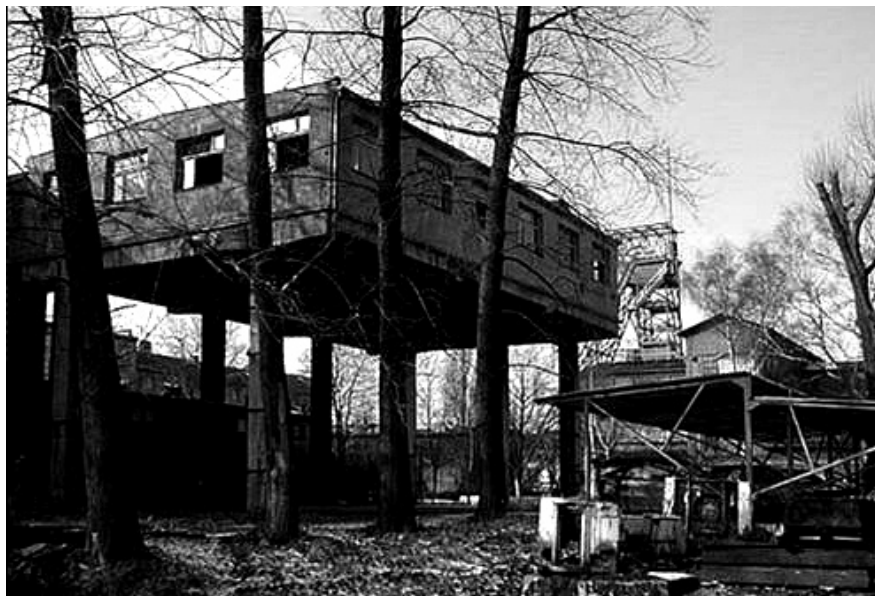
il. 27 Bytom, budynek dawnej lampiarni na terenie dawnych Zakładów Górniczo-Hutniczych „Biały Orzeł”
