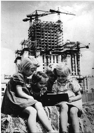
il. 8 Widok Pałacu Kultury i Nauki w Warszawie w trakcie budowy, 1952
