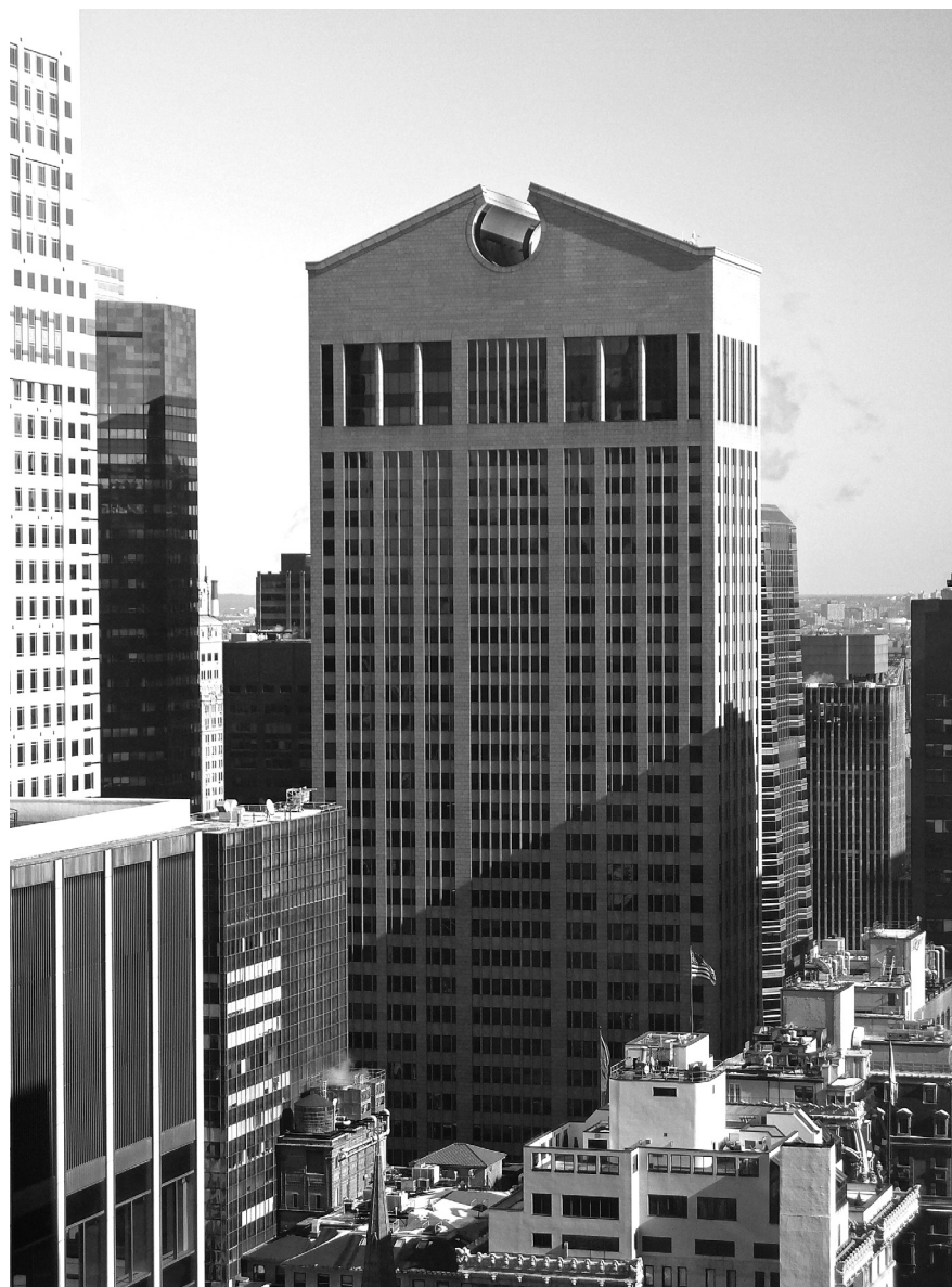
il. 4 Philip Johnson, Budynek siedziby AT&T (obecnie Sony Building), 1984, Nowy Jork. Fot. David Shankbone, za: Wikipedia
