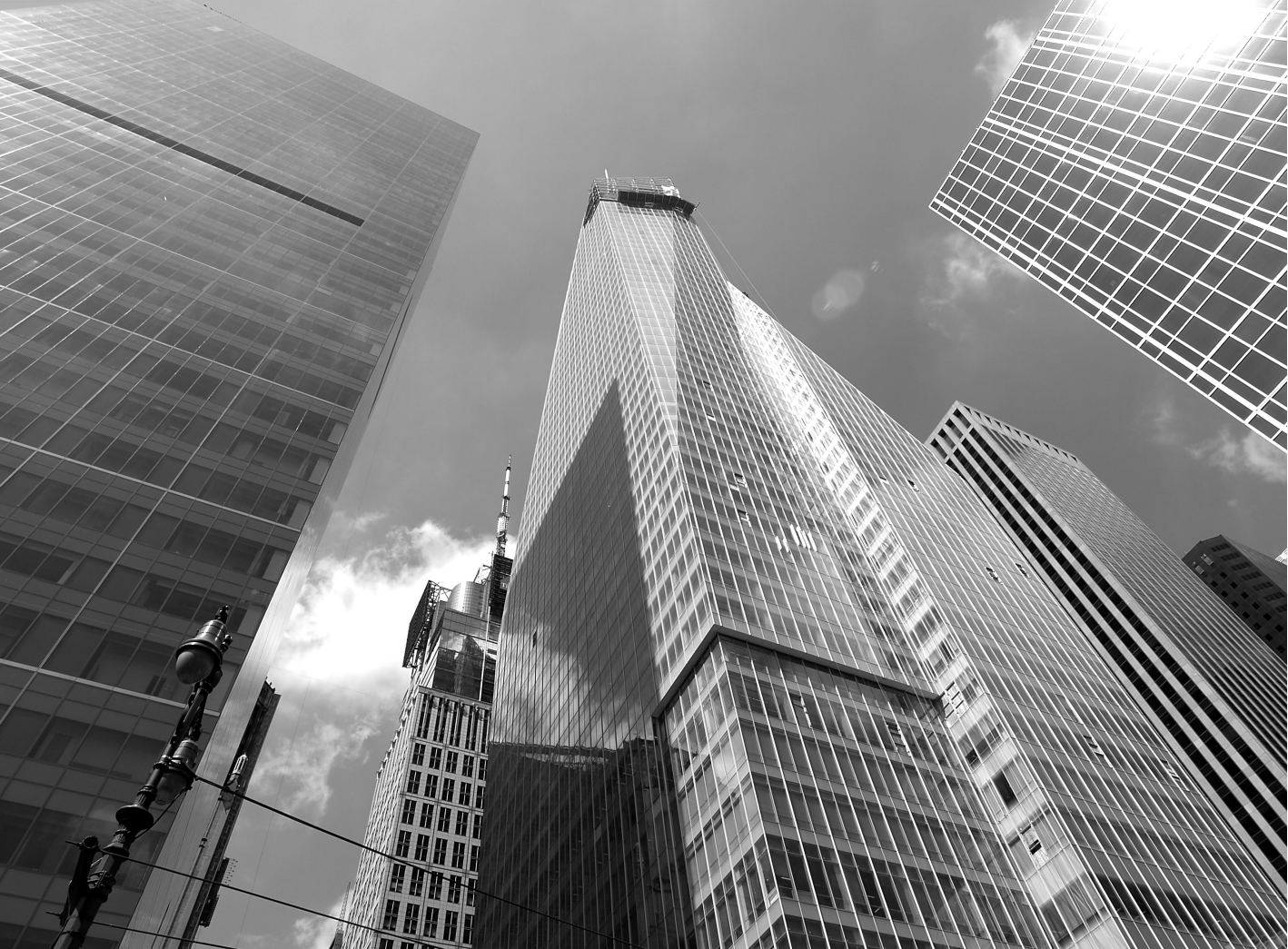
il. 20 Wieżowiec 1 Bryant Park (Cook + Fox Architects), fot. R. Eysymontt.
