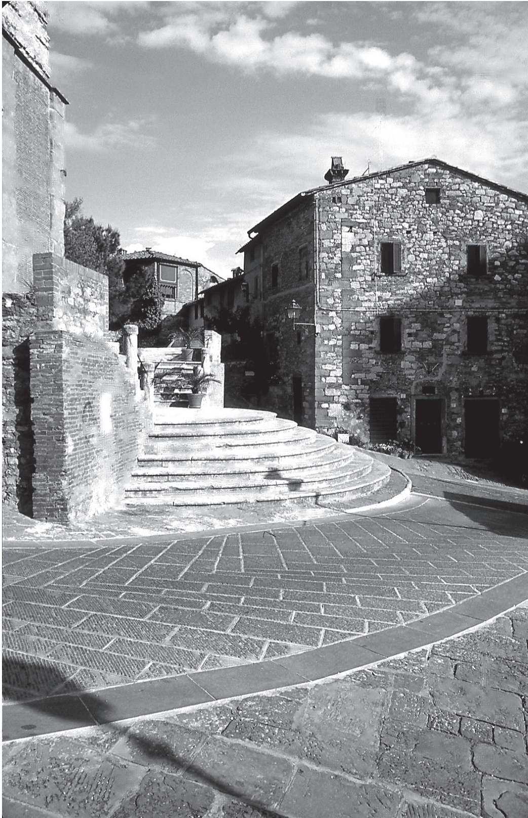
il. 14 Lucignano, schody na placu przed kościołem parafialnym. Fot. R. Eysymontt
