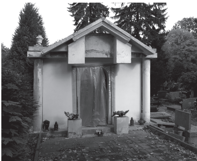
il. 18 Cmentarz Osobowicki we Wrocławiu. Mauzoleum ramskie w trakcie budowy. Fot. R. Eysymontt
