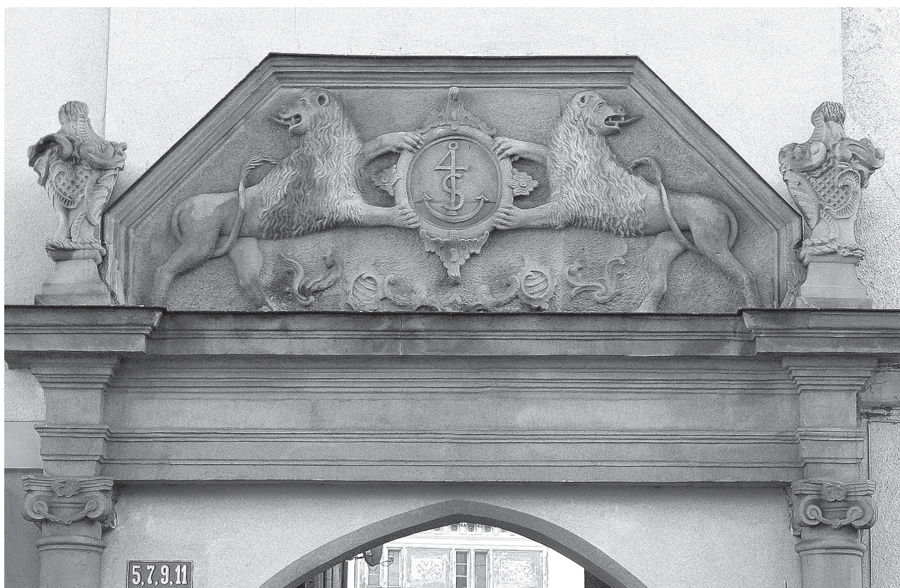
il. 16 Górna część portalu domu Sadebecków, stan obecny. Fot. R. Kaczmarek
