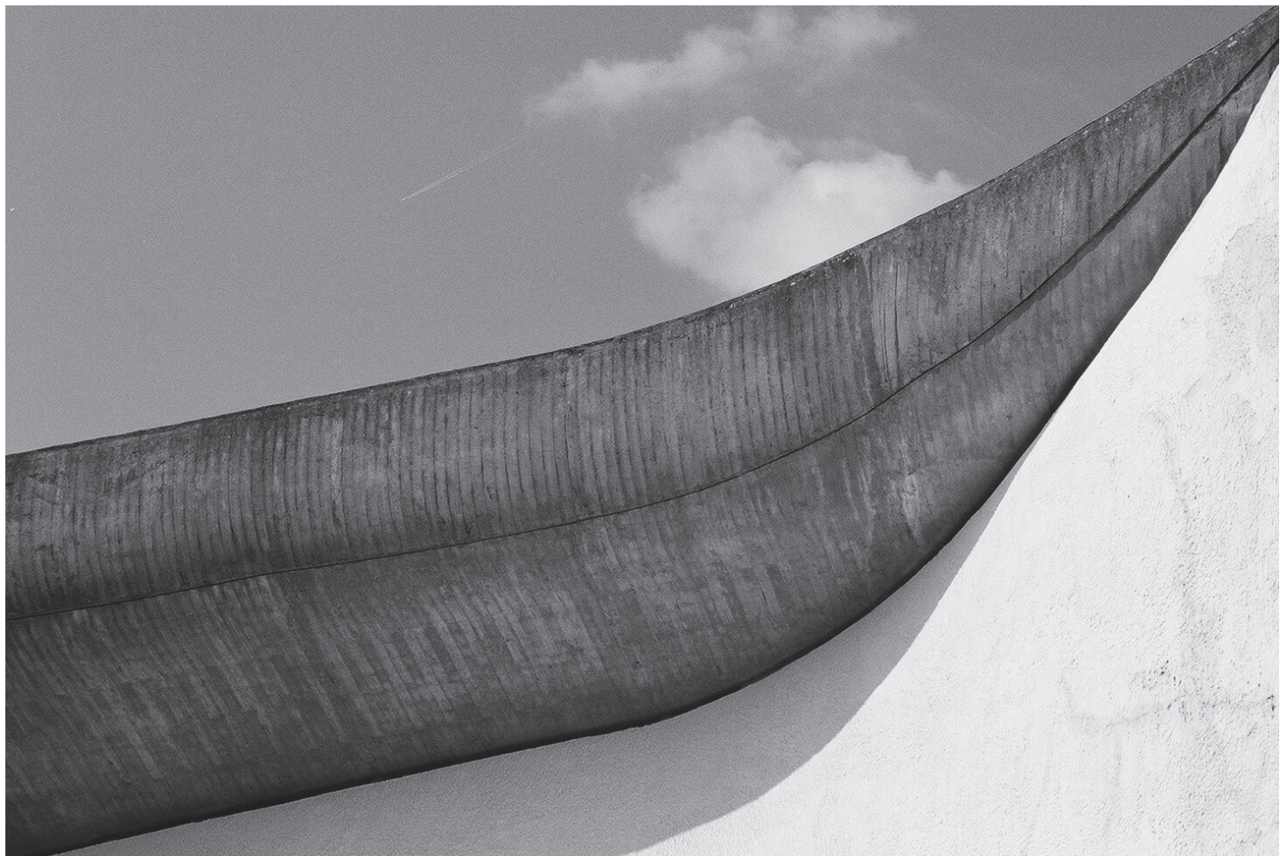
il. 8 Dach kaplicy w Ronchamp. Fot. A. Jarosz
