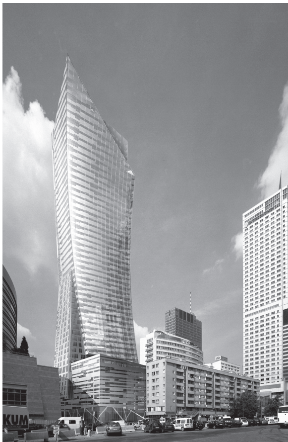
il. 5. Wieżowiec Złota 44, realizacja ok. 2012, Warszawa. © Studio Daniel Libeskind
