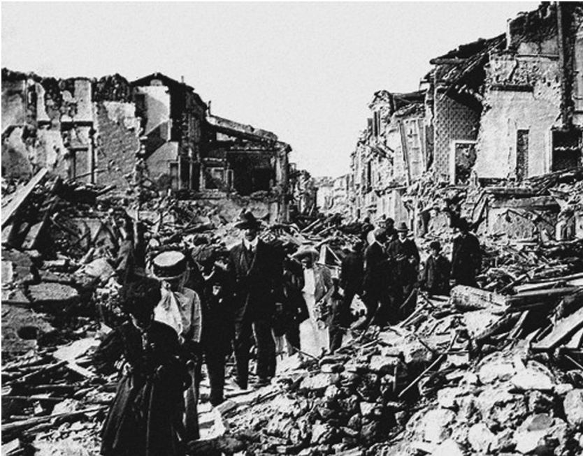
il.13 Mesyna zniszczona trzęsieniem ziemi, styczeń 1909
