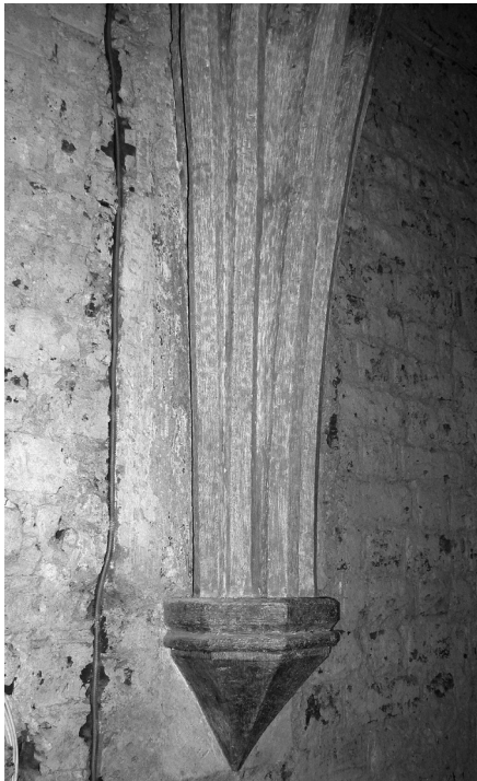
Il.3 Wspornik żeber sklepienia kaplicy św. Anny, kościół Franciszkanów w Opolu. Stan w trakcie prac konserwatorskich, styczeń 2008
