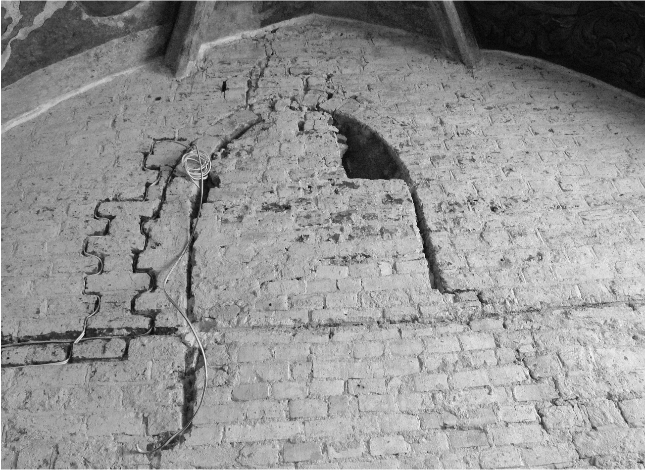
II.2 Zamurowane okno w ścianie ołtarzowej (południowej) kaplicy św. Anny, kościół Franciszkanów w Opolu. Stan w trakcie prac konserwatorskich, styczeń 2008
