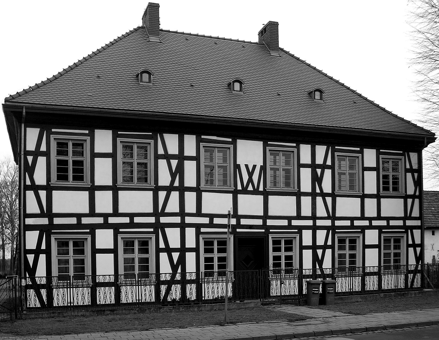
Il. 1 Budynek plebanii z 1626 r. – na pierwszym piętrze, w dwóch pomieszczeniach, znajdują się drewniane, polichromowane stropy belkowe. Fot. M. Kaluch-Tabisz
