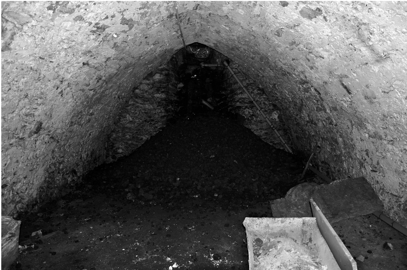
il. 2 Widok piwnicy, Rynek 8, Ziębice. Fot. R. Gliński
