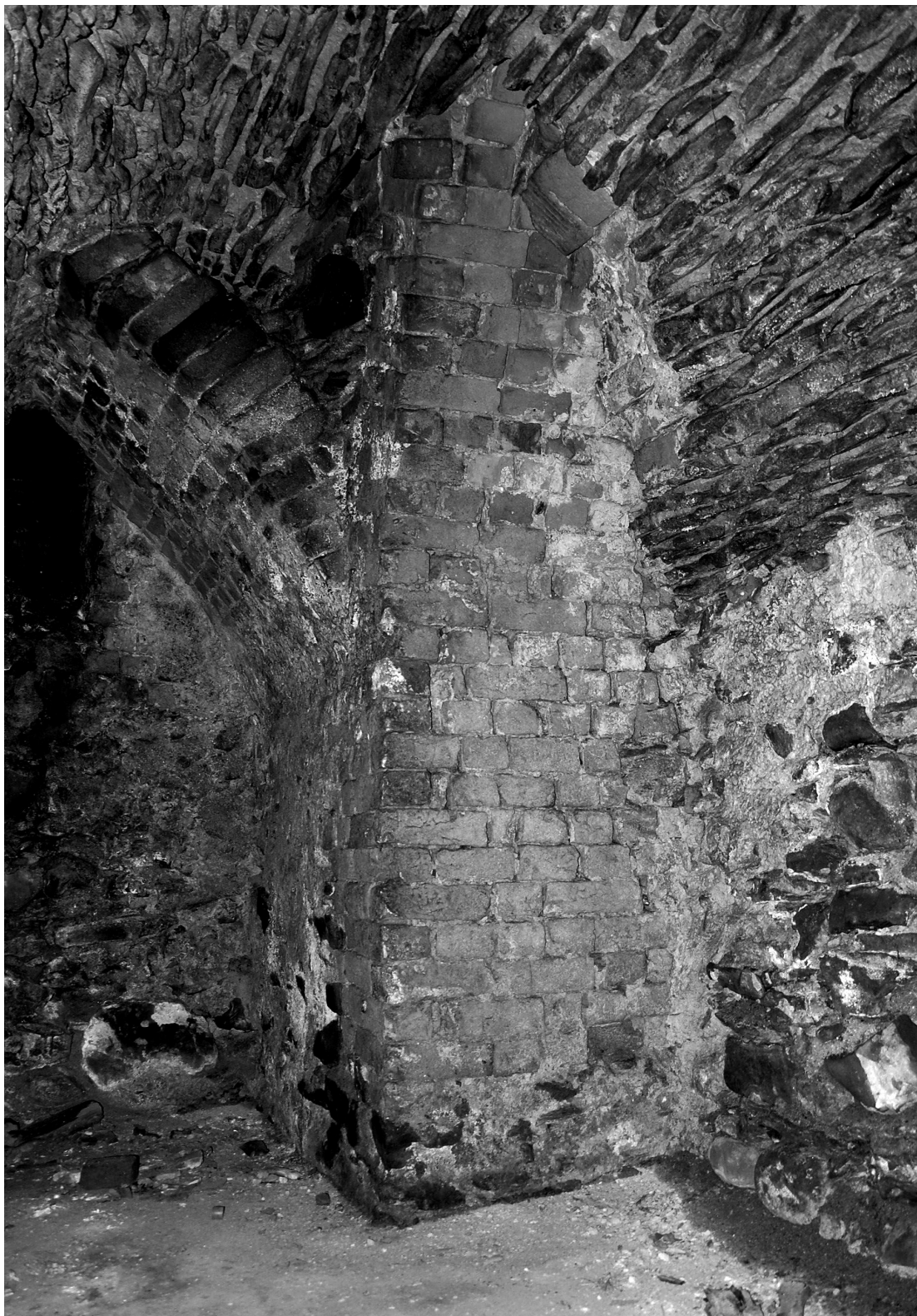
— il. 7 Filar fundamentu przebijający sklepienie kamiennej piwnicy, Rynek 37, Ziębice. Fot. R. Gliński
