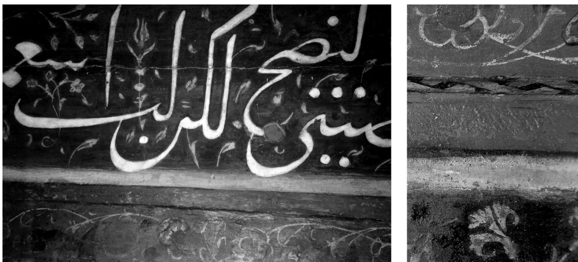
— il. 9. Strop w trakcie konserwacji, po usunięciu warstw przemalowań wtórnych. Fot. A. Babicka
