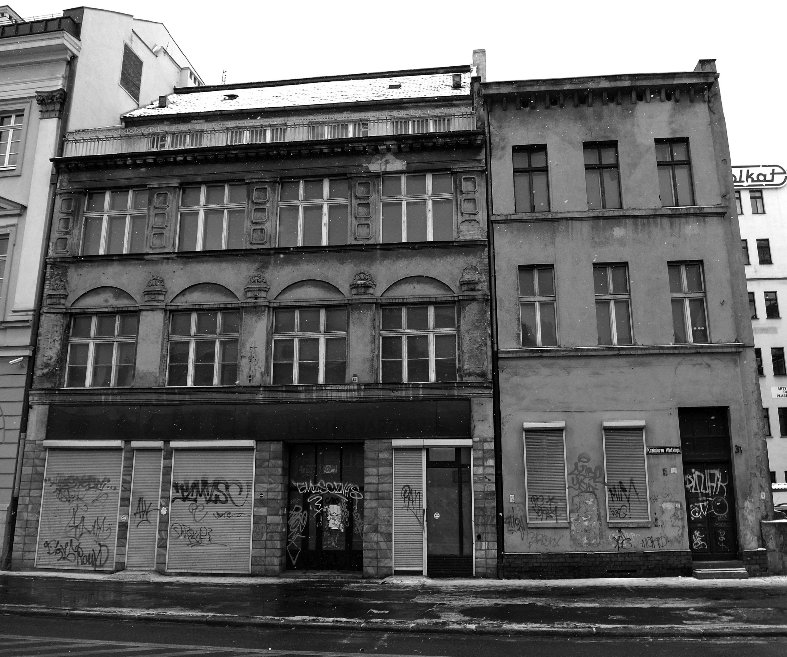
il. 2 Widok kamienic przy ulicy Kazimierza Wielkiego 31 i 33 przed remontem zimą 2013. Fot. R. Eysymontt
