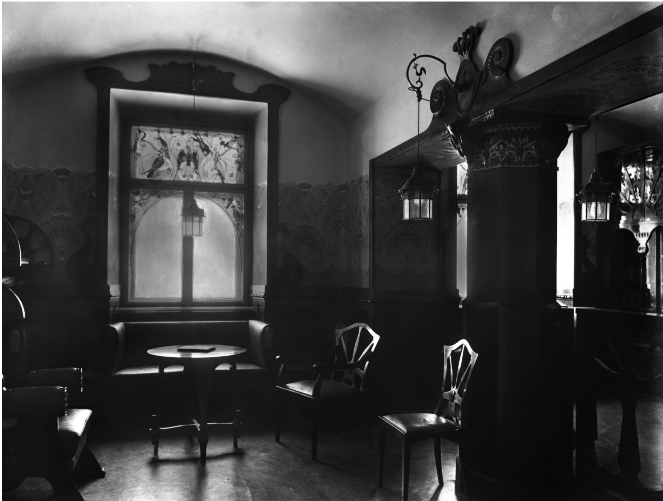
il. 16 Czytelnia w sanatorium Dłuskich, proj. K. Frycz. Fot. Muzeum Uniwersytetu Jagiellońskiego
