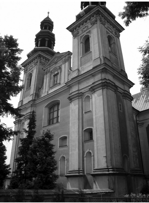
il. 10 Widok na wieże prezbiterium kościoła pocysterskiego w Łądzie. Fot. A. Stankiewicz
