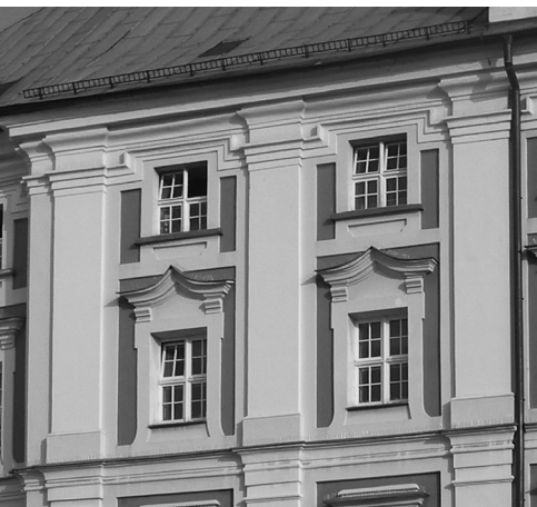
il. 7 Widok fragmentu elewacji zachodniej dawnego kolegium jezuickiego w Poznaniu. Fot. A. Stankiewicz
