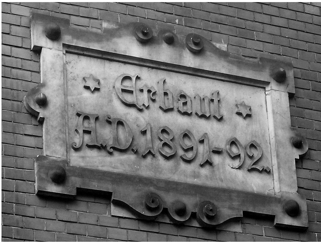
il. 8 Pałac w Kwietnie (Blumerode), fragment elewacji północnej z datą, 2004. Fot. K. Stefański
