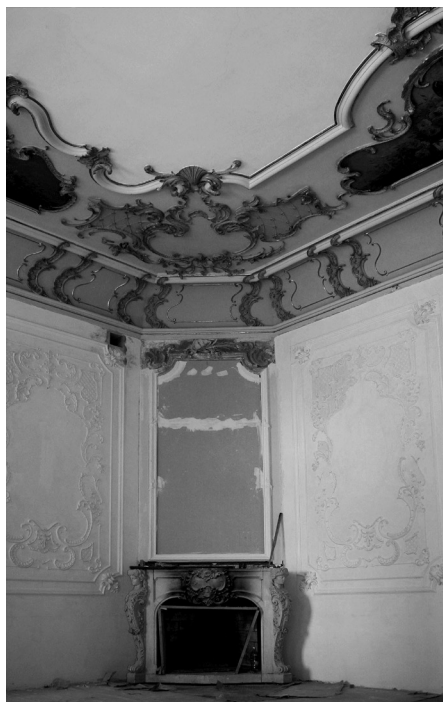
il. 11 Pałac w Kwietnie (Blumerode), salon gościnny w trakcie prac renowacyjnych, 2012. Fot. E. Grochowska
