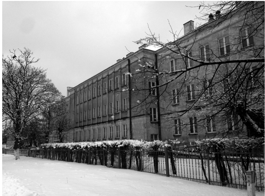
il. 5 Budynek administracyjny przy ul. Szczepreskiej proj. Rolfa Gutbiera. Fot. Aleksandra Paradowska
