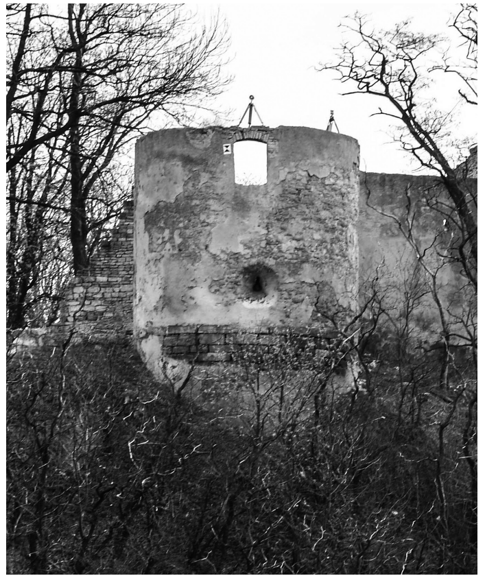
il. 2 Hża, woj. mazowieckie. Przykład tradycyjnego odtworzenia fragmentu bastei zachodniej – obiekt przed rekonstrukcją (po lewej; źródło: Narodowe Archiwum Cyfrowe) oraz po fragmentarycznej rekonstrukcji, z nałożonym tynkiem współczesnym (po prawej; fot. R. Zapłata, 2012). Widok obiektu od strony zachodniej. Odtworzenie ubytków bastei po nałożeniu tynków nie jest widoczne
