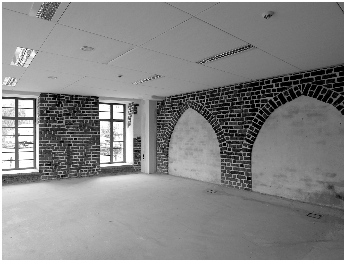
il. 6 Arkady w ścianie południowej dawnej kaplicy w trakcie prac remontowych w 2008 roku. Fot. R. Eysymontt
