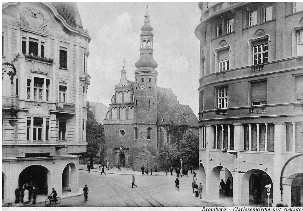
il. 11 Zbieg dzisiejszych ul. Focha i pl. Teatralnego z kamienicami przebudowanymi w dolnych kondygnacjach. Pocztówka z lat 40. XX w., ze zbiorów prywatnych M. Ogródowicza
