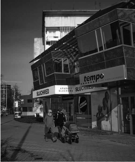
5. Kompozycja wschodniej pierzei ul. Piłsudskiego ukształtowana z ułożonych naprzemiennie mieszkalnych punktowców i pawilonów usługowych. Przykryty wiszącym dachem o konstrukcji linowej pawilon poczty (projekt: Bogna Klimczewska, konstrukcja: Leszek Zgagacz) został wyburzony w 2007. Fot. M. Duda The eastern frontage of Piłsudskiego Street was composed of alternating residential tower blocks and service pavilions. The post office pavilion covered by a suspended rope roof (design: Bogna Klimczewska, construction: Leszek Zgagacz) was demolished in 2007. Photo: M. Duda
