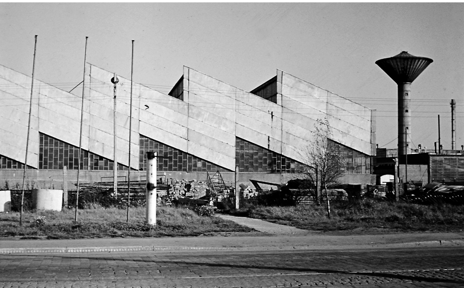
6. Nowa hala Zakładów Hutniczo-Przetwórczych Metali Nieżelaznych „Hutmen” w budowie. Fot. O. Czerner, zbiory Muzeum Architektury we Wrocławiu
