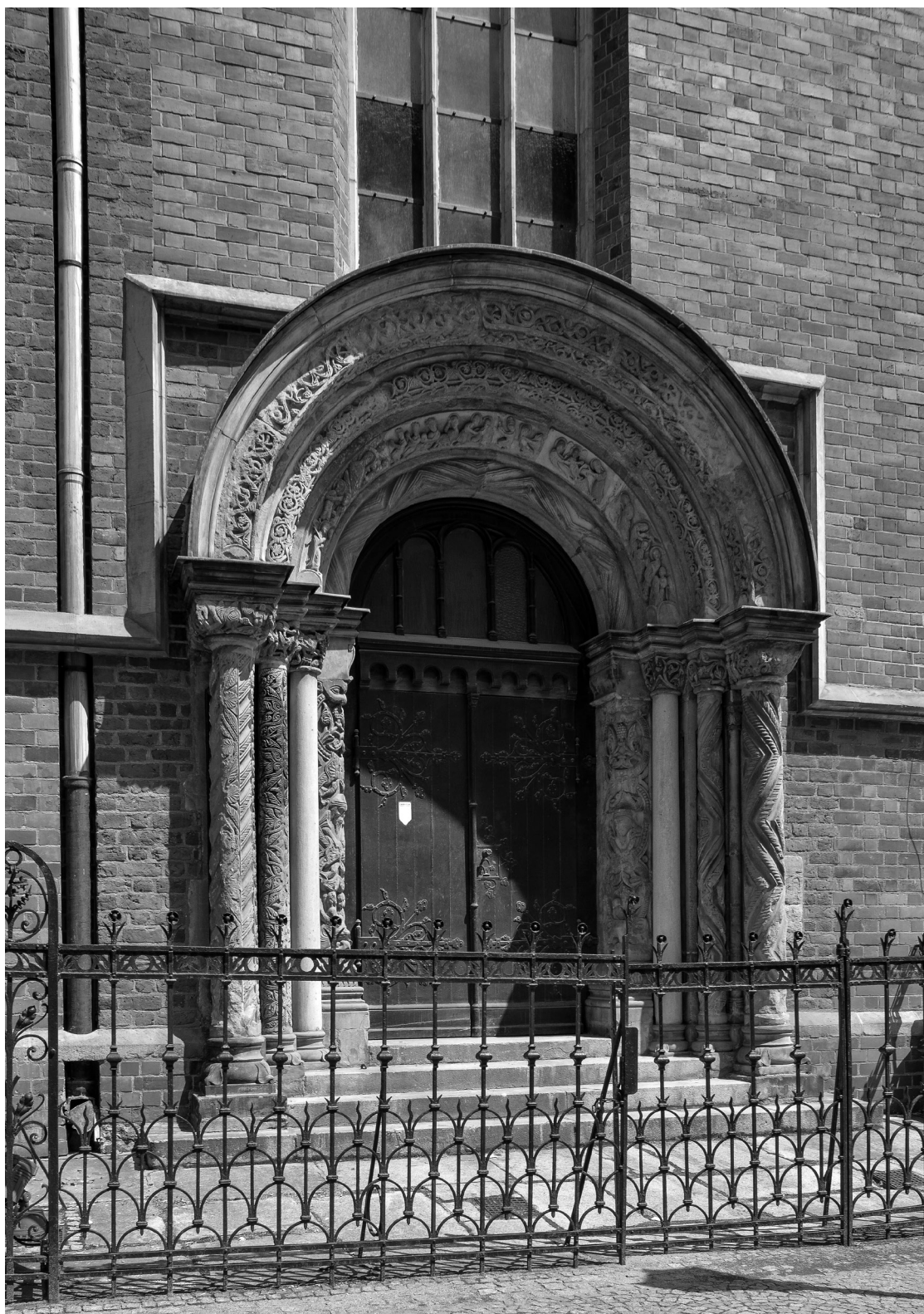
1. Kościół pw. św. Marii Magdaleny we Wrocławiu, lipiec 2022 - elewacja południowa, portal z romańskiego opactwa Benedyktynów na Ołbinie, rozebranego na wniosek protestanckiej rady miejskiej w 1529 roku. Portal wmontowano do już wówczas ewangelickiego kościoła w 1546 roku. Fot. J. Kos
